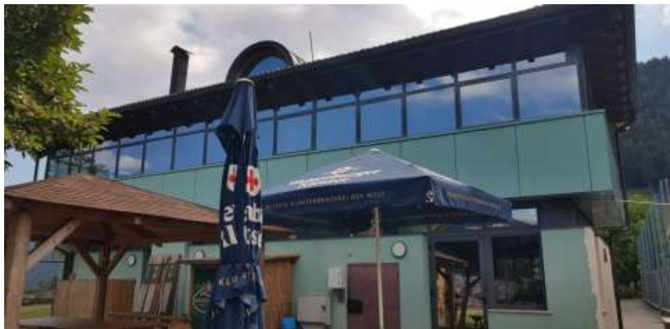
Figura 12- foto della palazzina servizi
